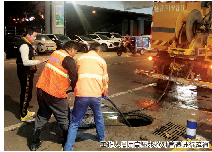
工作人员用高压水枪对管道进行疏通
