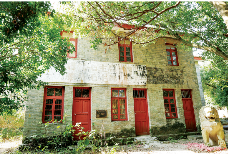
新圩贮木厂已被列入我市第二批历史建筑名录的苏式建筑。
