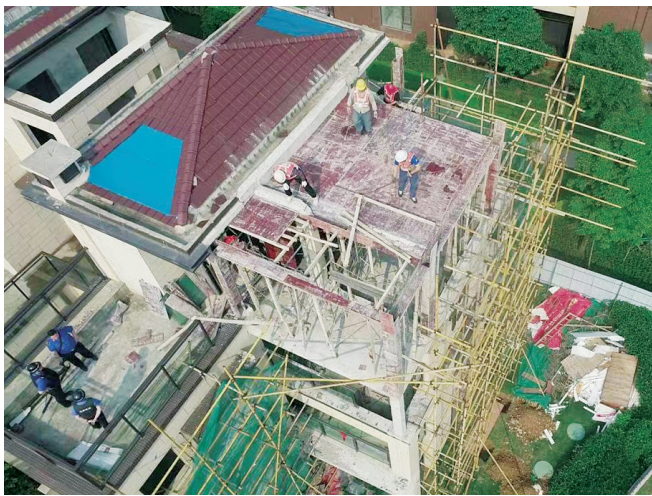
执法人员实施拆除情景。
