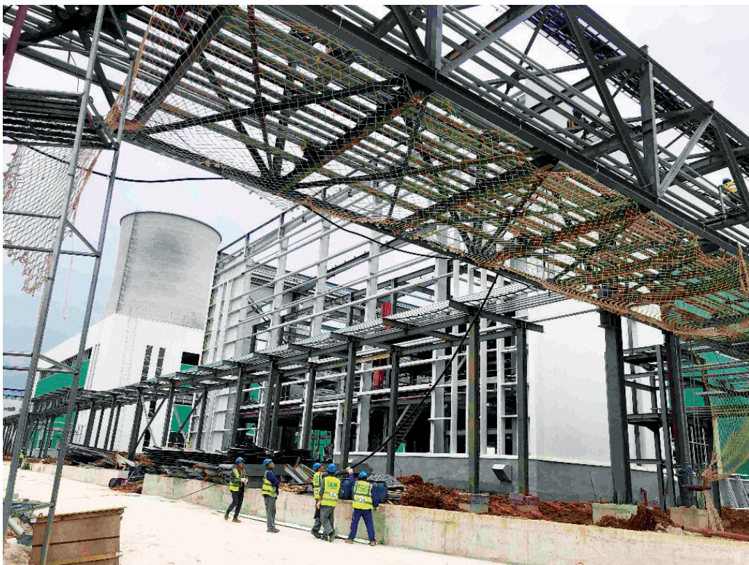
鹿寨县新能源产业园区标准厂房及配套基础设施建设项目一期工程的施工现场。
