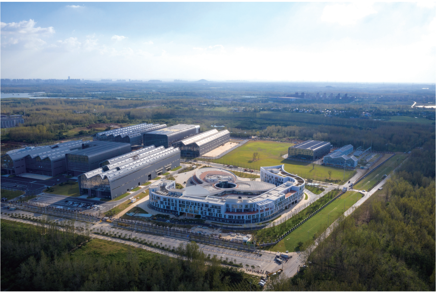
聚变堆主机关键系统综合研究设施园区全景(2021年9月12日报)。(新华社发)
