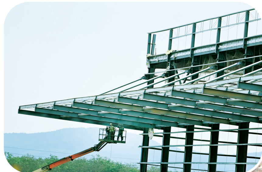
↑工人抓紧施工。
