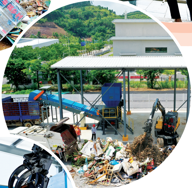
↑24日上午，柳州市大件垃圾拆解中心现场。
