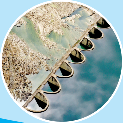
糯米滩水力发电厂连拱坝
