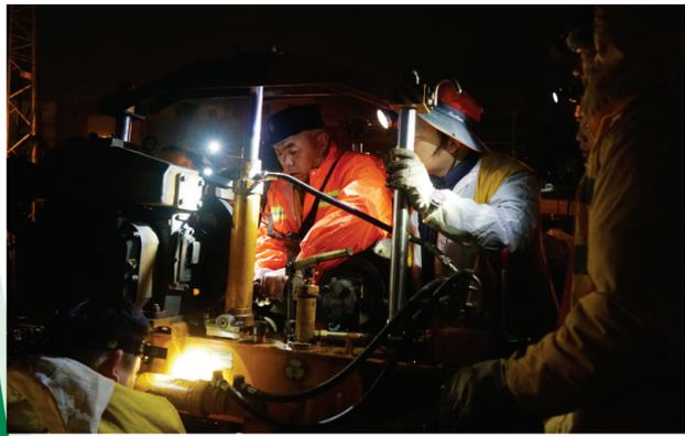
铁路工人正在进行线路捣固作业。
