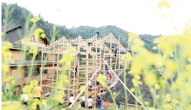
工人在搭建木结构建筑。 本报通讯员 龚普康 摄
