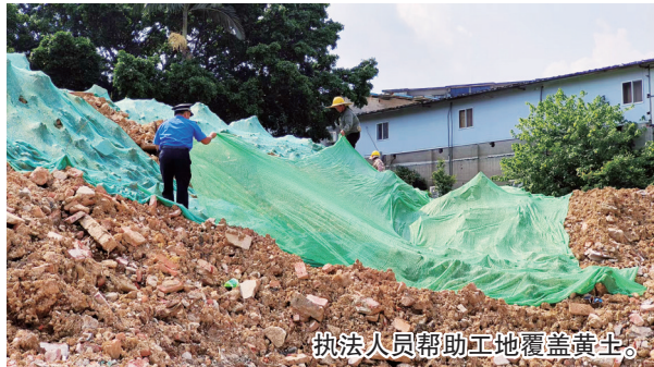
执法人员帮助工地覆盖黄土。
