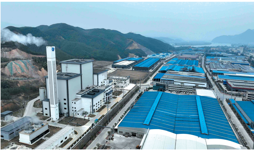
位于融安·广西香杉生态工业产业园一侧的广西广投康恒新能源有限公司源源不断地向产业园所有企业集中供热。
