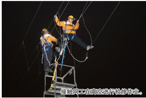
接触网工在高空进行检修作业。
