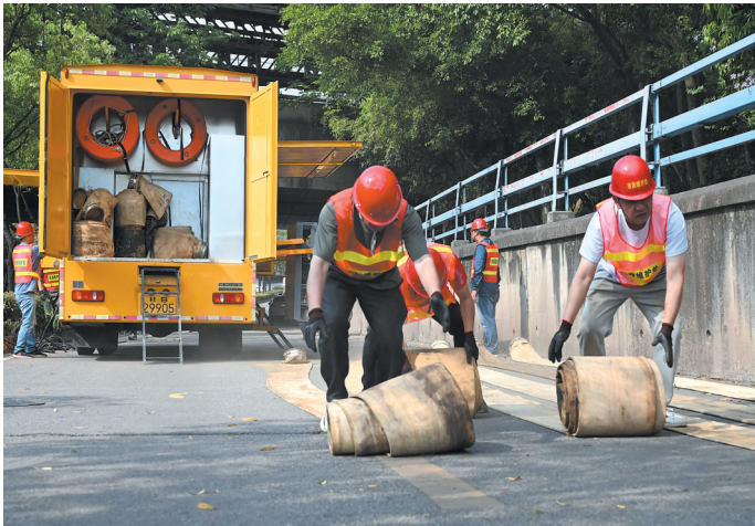
演练人员铺设排水带。
