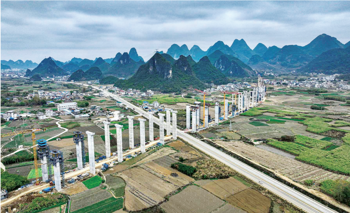
广西梧州至乐业高速公路项目（鱼峰至宜州段）施工现场。本报通讯员 罗春宇 摄
