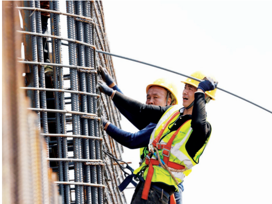
工人在绑扎桥墩钢筋。
