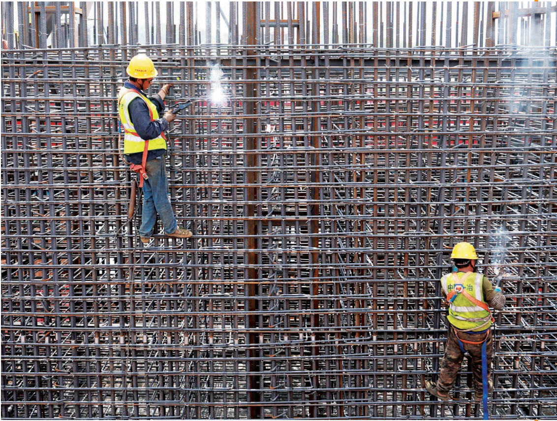
工人在焊接桥墩钢筋。
