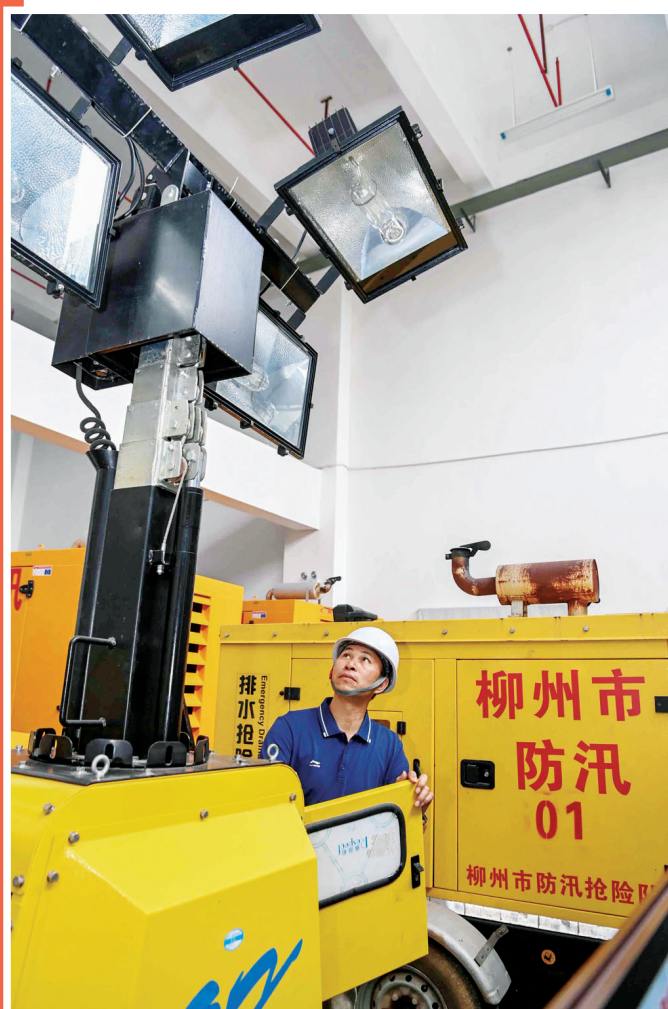
调试全方位移动照明灯塔。
