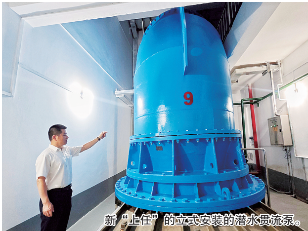
新“上任”的立式安装的潜水贯流泵。
