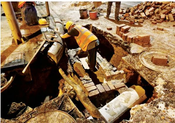
施工人员进行连夜施工。
