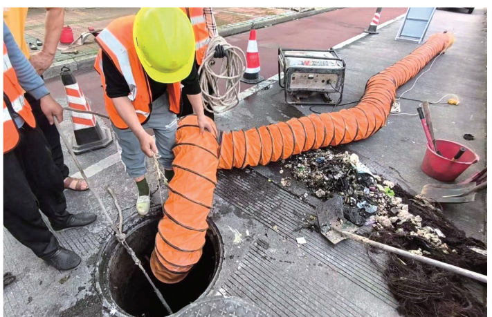
施工人员运用鼓风机在井口进行通风作业。 (市市政设施维护管理处排水维护所供图)
