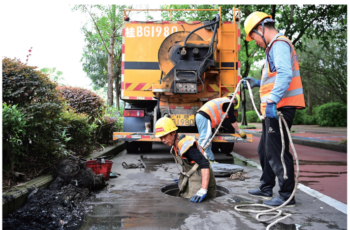
施工人员准备下井疏通污水管道。
