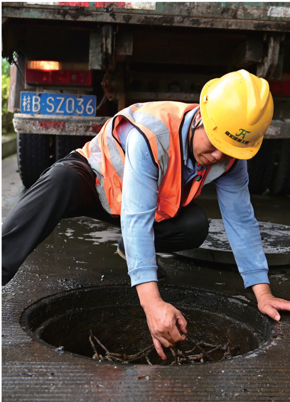
作业结束后，施工人员套上井盖安全防坠网。
