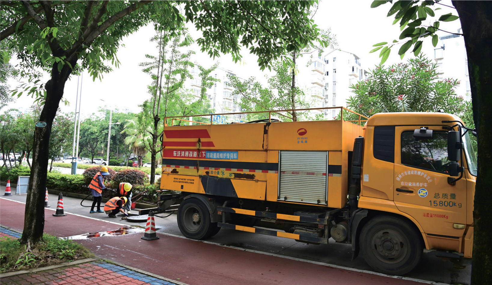
运用高压喷水枪冲刷排水管道。
