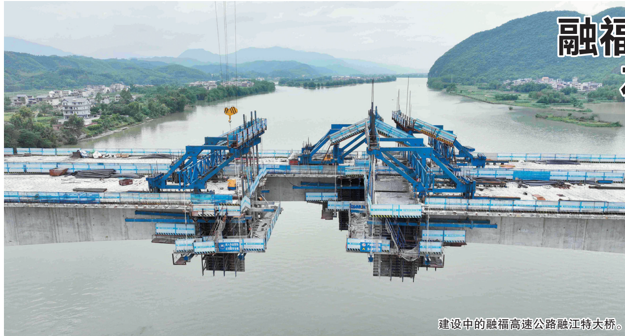
建设中的融福高速公路融江特大桥。
