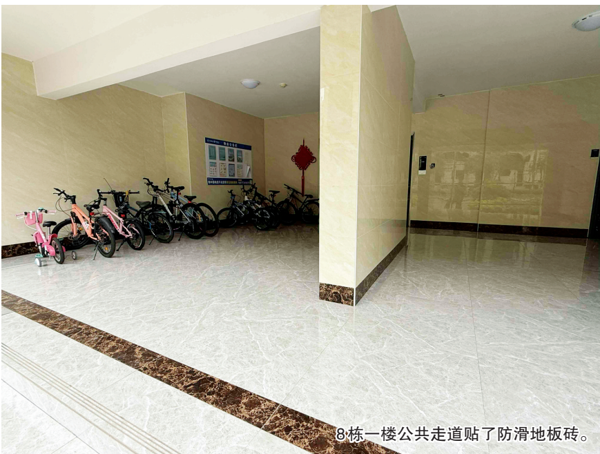
该小区10栋一楼公共走道现状。
