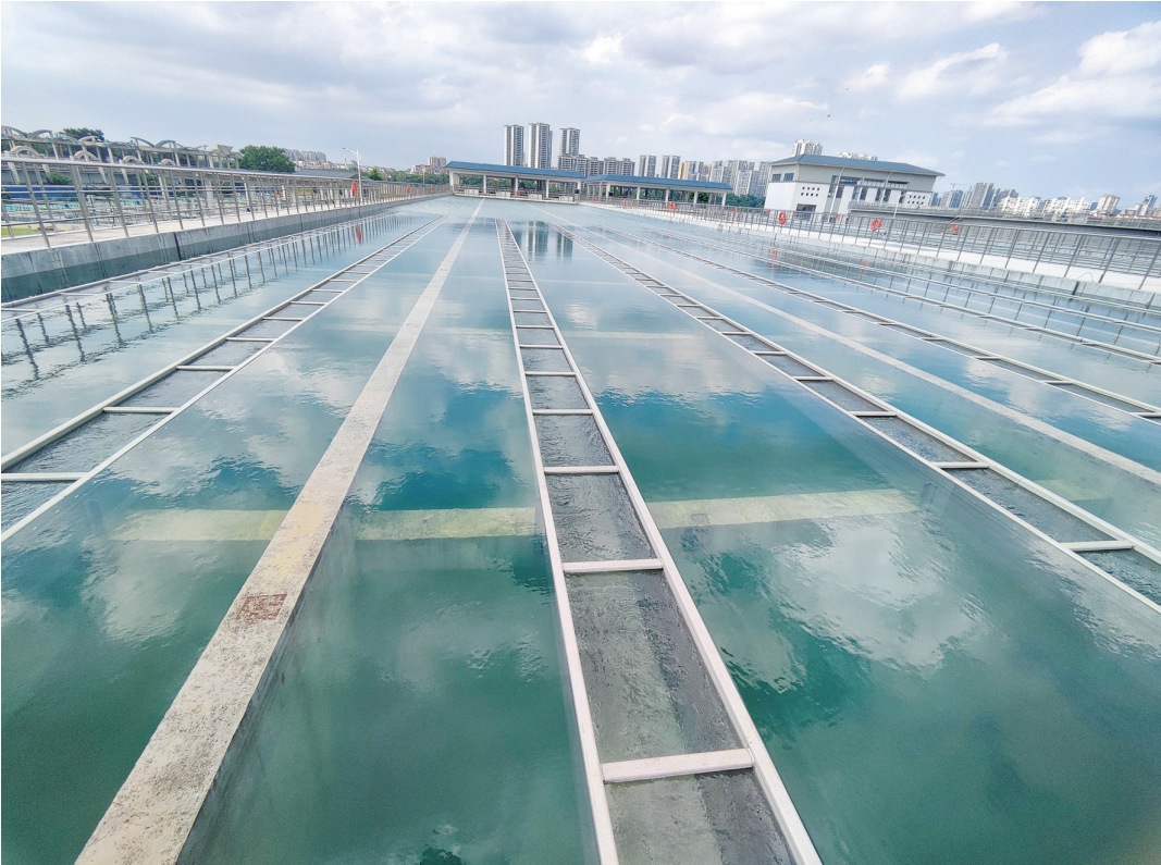
柳西水厂三期工程沉淀池。
