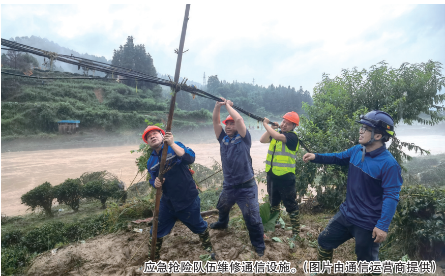
应急抢险队伍维修通信设施。(图片由通信运营商提供)
