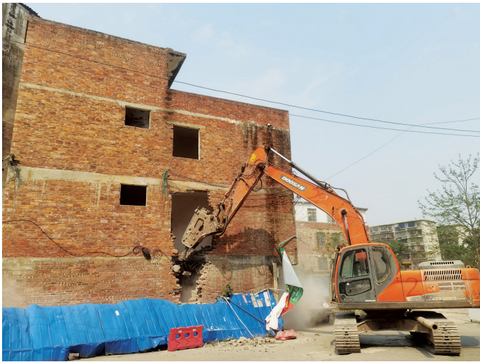
柳南区新云村城中村改造项目征拆现场。
