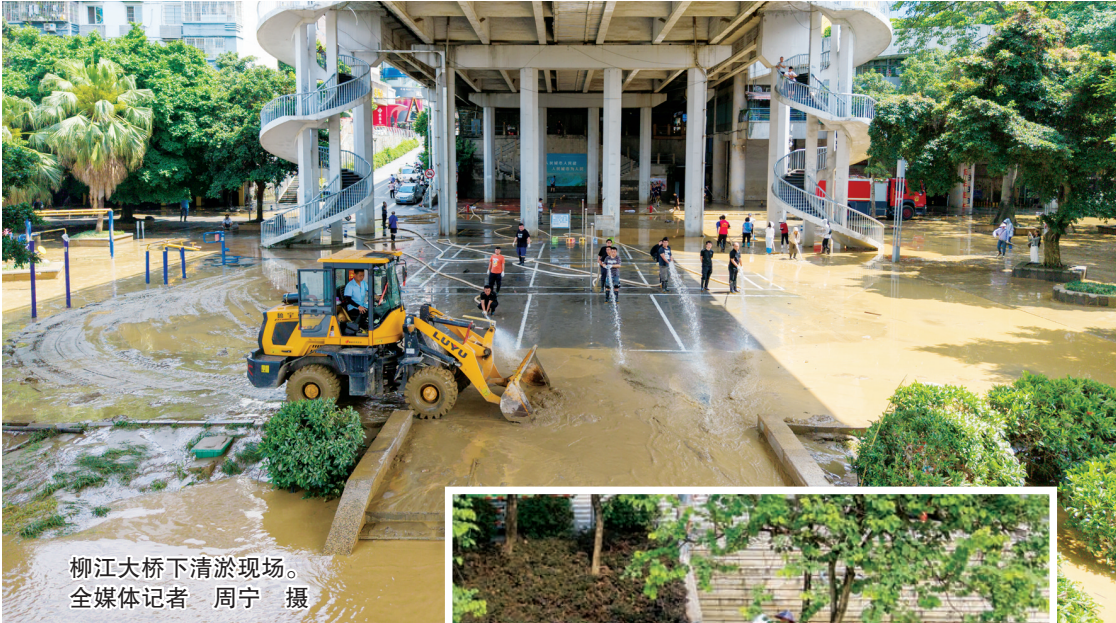
柳江大桥下清淤现场。全媒体记者 周宁 摄
