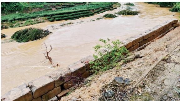
↑利用配重块筑起约60米长的防洪挡土墙。（图片均由三江公路养护中心提供）
