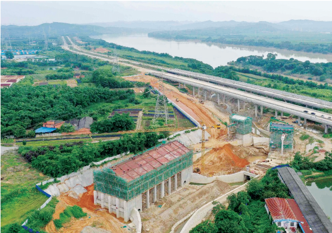
沙塘泵站建设现场。
