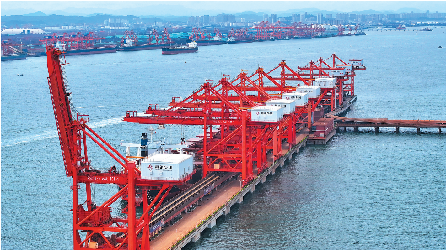
柳钢防城港基地原料码头港机列阵而立。
