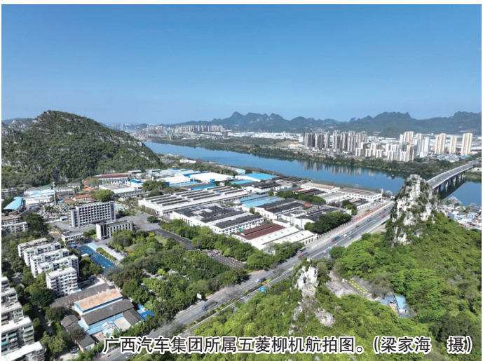
广西汽车集团所属五菱柳机航拍图。(梁家海 摄)
