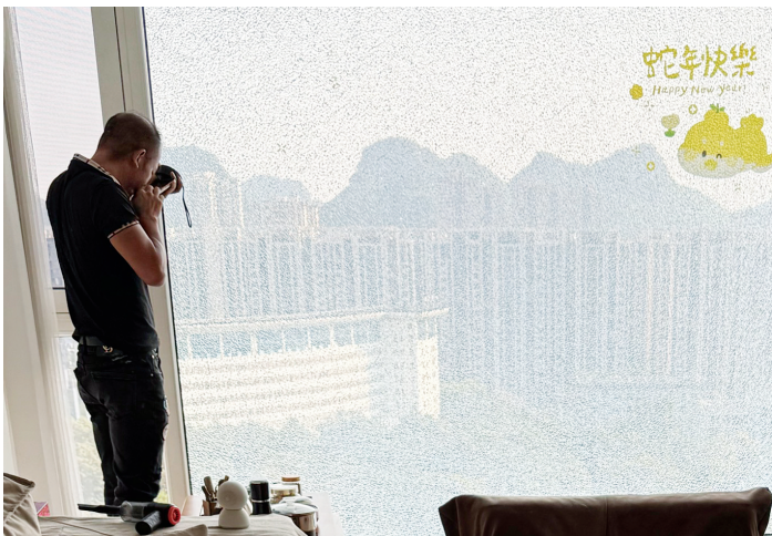
厂家工作人员到市民家中检查玻璃碎裂情况。
