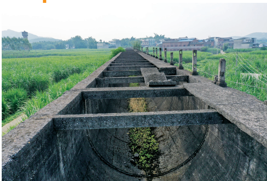
↑渡槽延伸到水沟屯。
