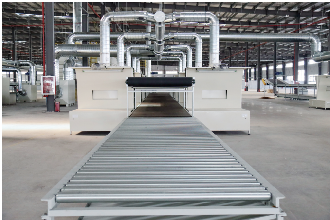
深圳爱博绿废旧电器电子循环再利用项目新装生产线。
