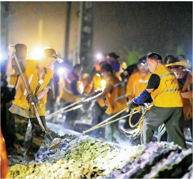
热火朝天，铺设道砟。
