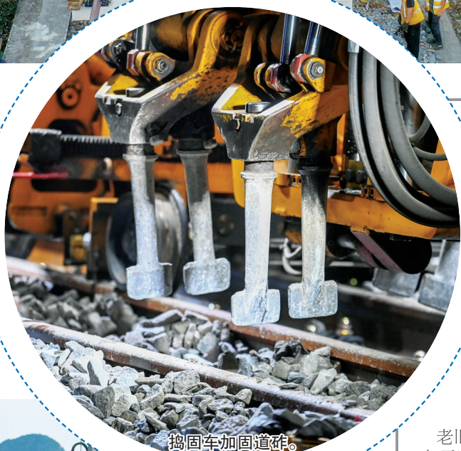
捣固车加固道砟。
