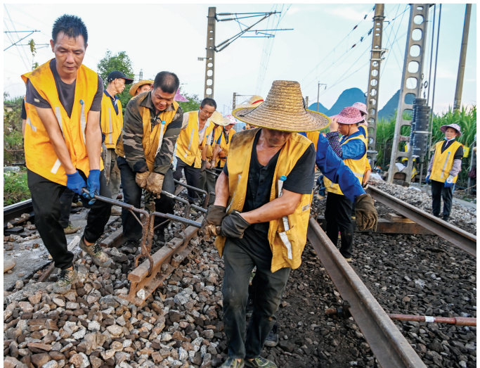
齐心协力，拆卸换新。
