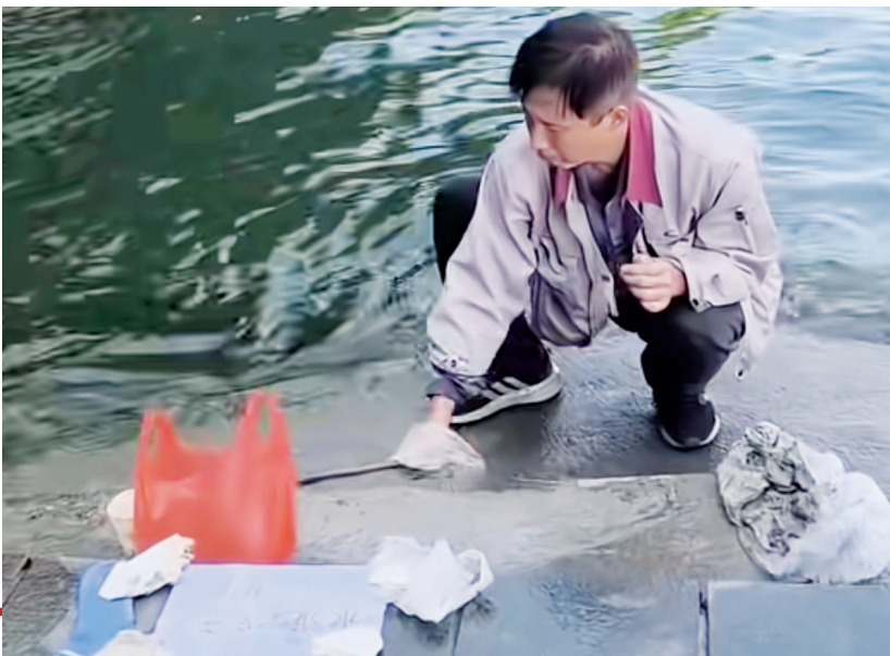
“水手”在修补游泳平台上的缺损处。
