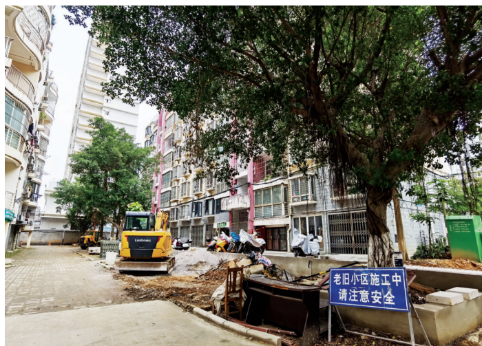
工程车辆进入潭中明园北园施工。
