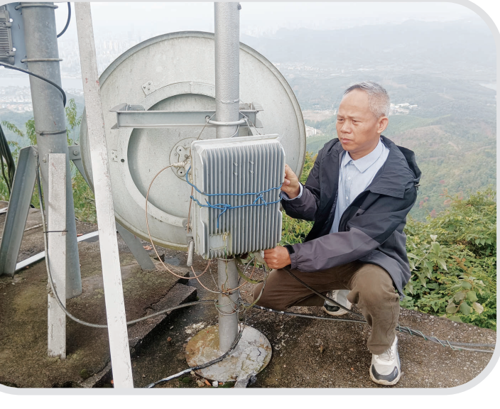
廖壮真正在检修维护设备。
