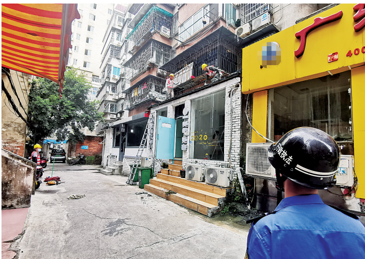
金鱼巷拆除违建现场。
