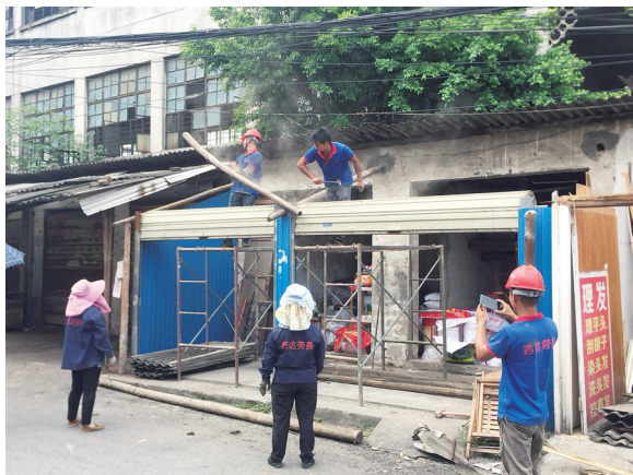
城管部门组织人员拆除违建棚子。
