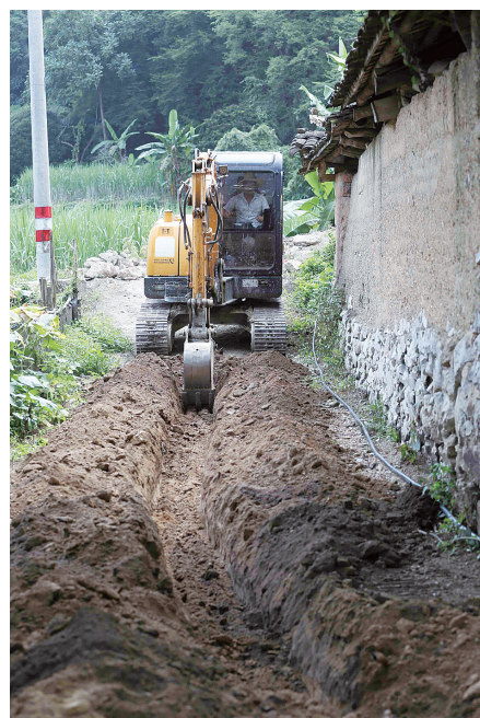
挖掘机在挖水槽。
