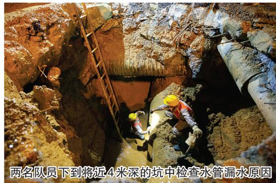
两名队员下到将近4米深的坑中检查水管漏水原因。
