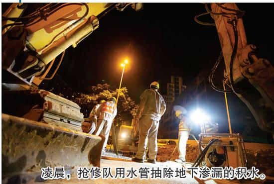
凌晨，抢修队用水管抽除地下渗漏的积水。
