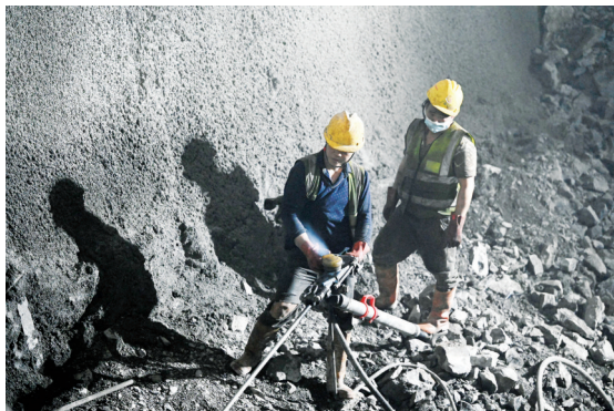
在六绵山隧道，工人在大山深处开展钻孔作业。
