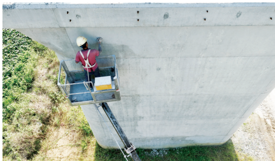
工人在古楼特大桥桥墩前进行收尾施工。
