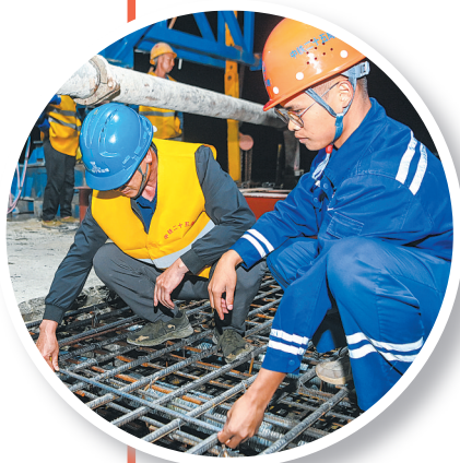
↑工人在测量作业。
