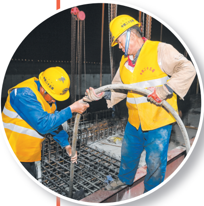
↑工人正在浇筑混凝土。
