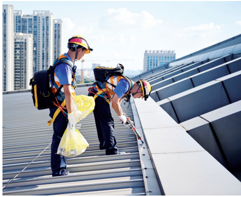
黄鹤(右)修补屋面的裂痕。
