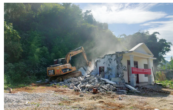
拆除占用耕地林地违建现场。
