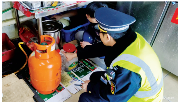
执法人员检查燃气管连接是否稳固。
