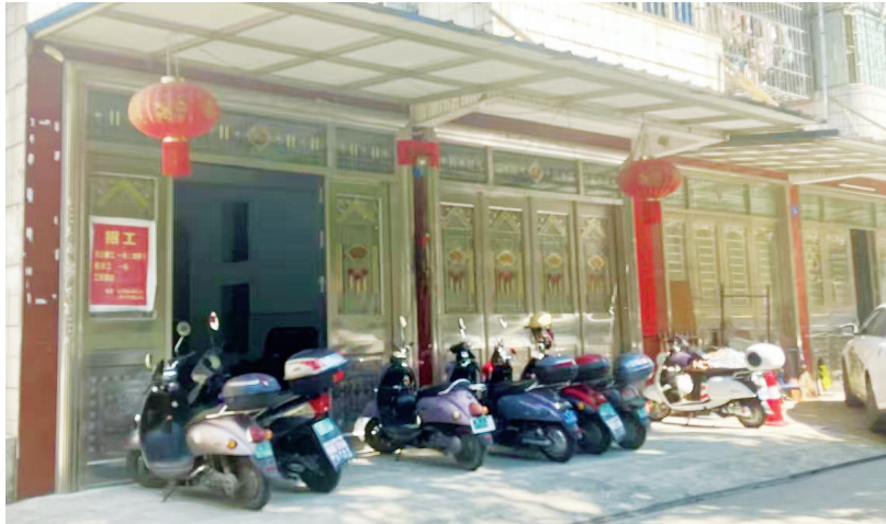
东苑小区一民房门口停满车子,但没有安装烟感报警器等设备。
