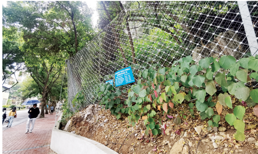
广西科技大学螺蛳山脚安装防护网阻挡危石滚落。(资料图片)
