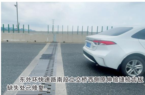
东外环快速路南段立交桥西侧原伸缩缝梳齿板缺失处已修复。
