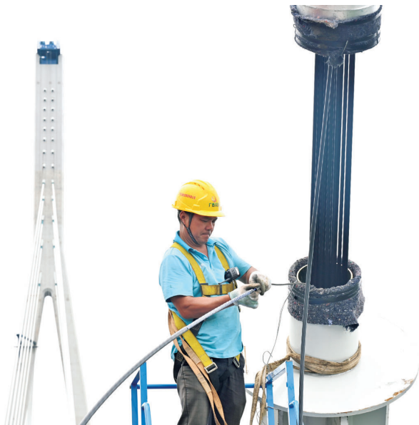
↑钢绞线拉索到位后，桥面工人对斜拉索进行连接作业。
