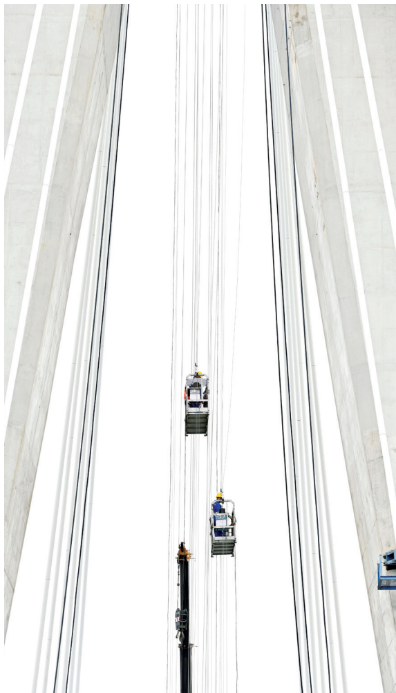
↑工人乘坐升降吊笼进入高空作业区。
